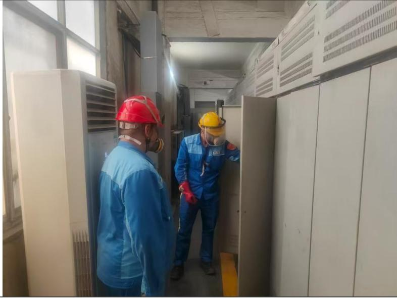
抢修组对尾气风机电源紧急排查处理
